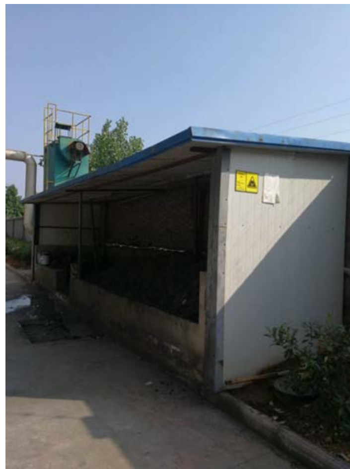
废金属切削加盖顶棚
